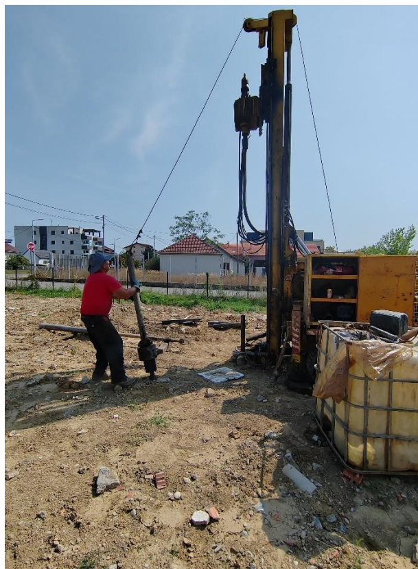
Slika 11. Fotografije tijekom izvođenja istražnih radova
