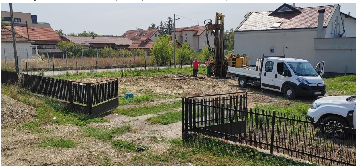
Slika 1. Prikaz provođenja geotehničkih istražnih radova
